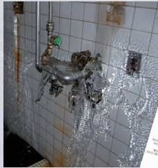
▲水道管破裂
